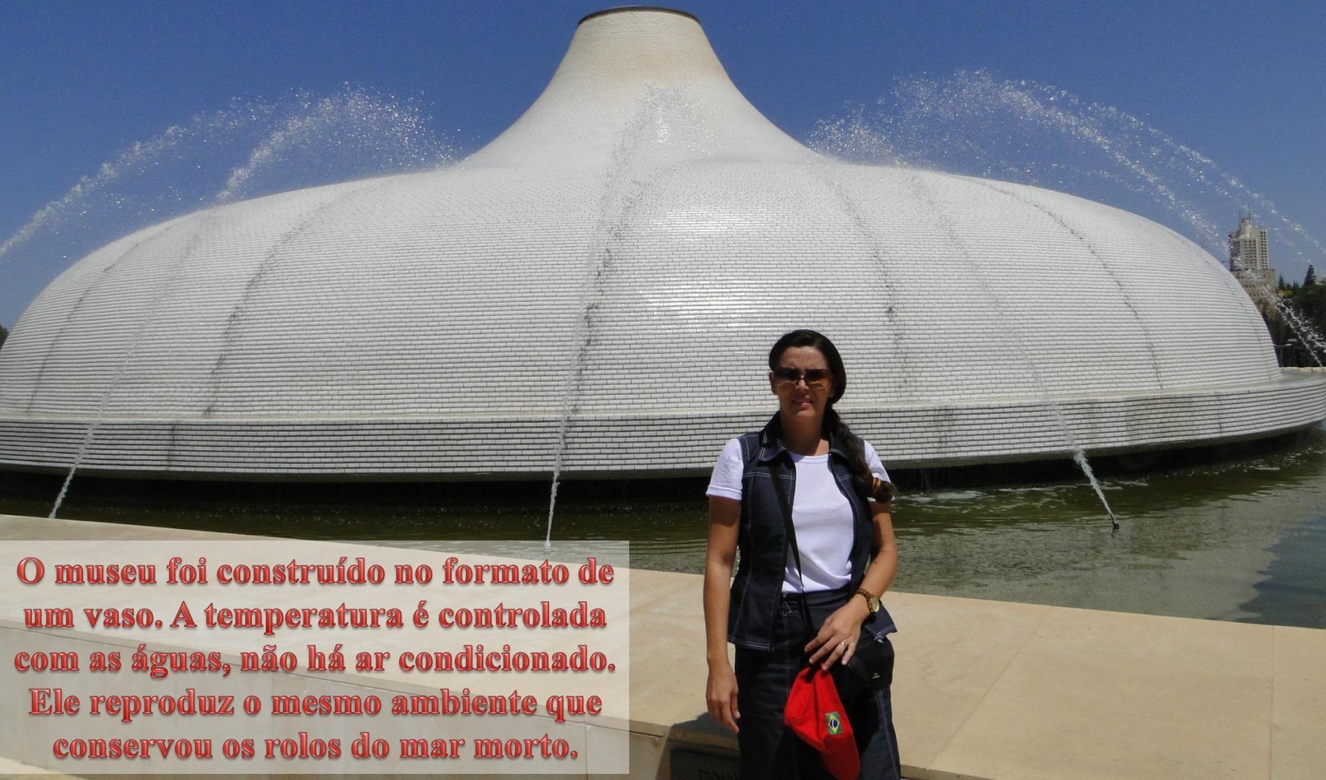
**O museu foi construído no formato de um vaso. A temperatura é controlada com as águas, não há ar condicionado. Ele reproduz o mesmo ambiente que conservou os rolos do mar morto.**
